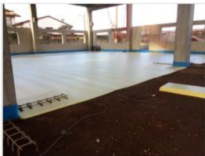
Posa isolante per impianto di riscaldamento
