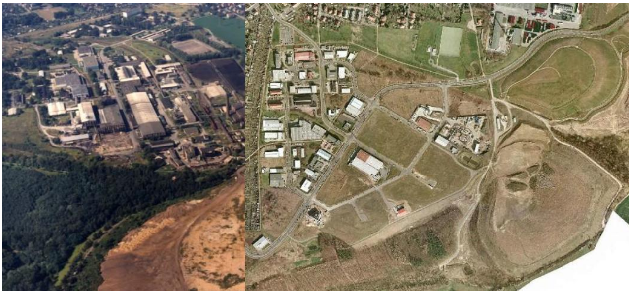
Esempio di riqualificazione ad uso produttivo ed artigianale (previa messa in sicurezza) di sito ex fabbrica statale per lavorazione minerali contenenti uranio.
